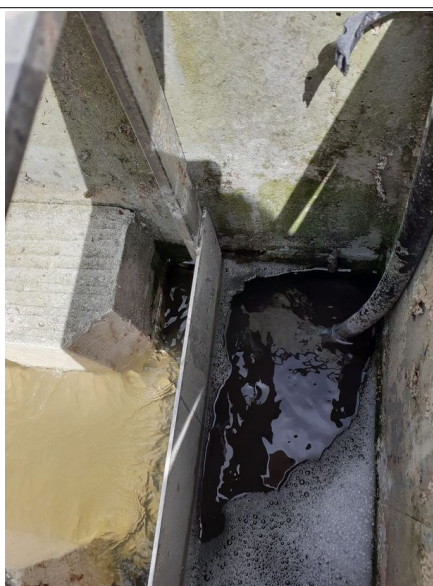
Présence d'algues ne permettant pas de s'assurer du bon positionnement du canal de prélèvement
